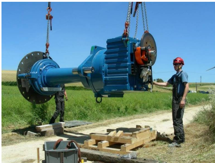
Figure 16 : Changement d'une génératrice sur le parc éolien d'Avignonet-Lauragais (Haute-Garonne)
