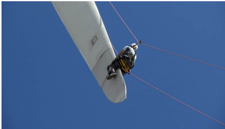
Figure 14 : Inspection d'une pale sur le parc éolien d'Avignonet-Lauragais (Haute-Garonne)
